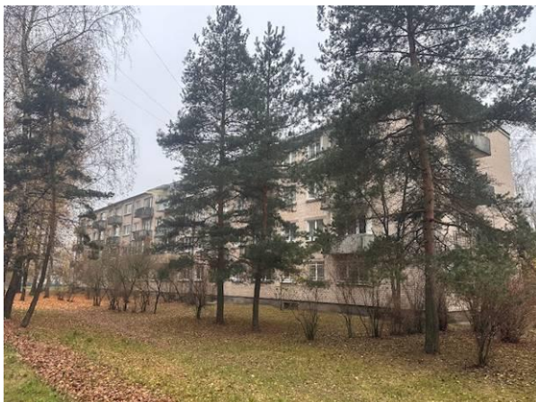
Skats uz ēku no Ikšķiles ielas puses
